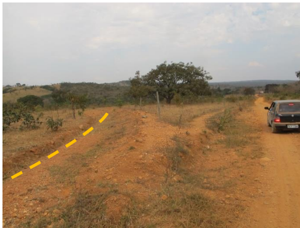
Foto 13: Vista da estrada de acesso onde foi indicada a execução de barraginhas tipo 1 (Coord. UTM 613091 / 7879128).
