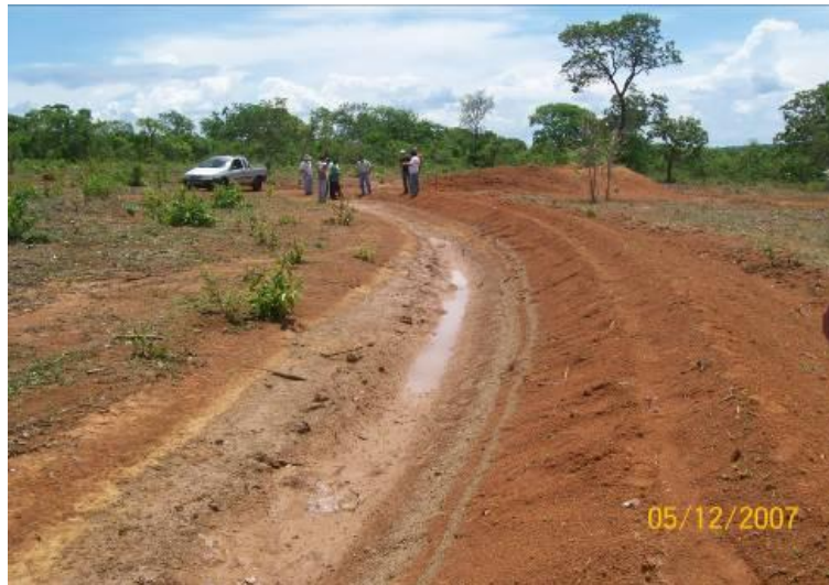
Figura 14: Exemplo de terraço executado
